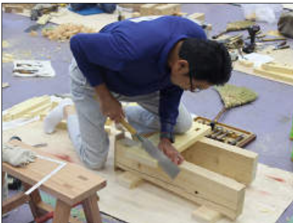
【競技風景 建築大工①：ポリテクセンター千葉】
